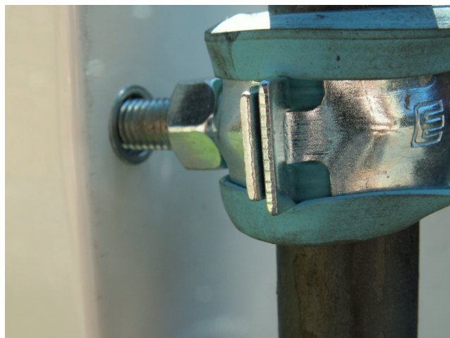
Närbild på infästning mot skåp.
