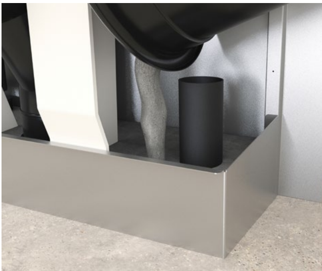
Schaktbotten och eventuell håltagning gjuts igen.
