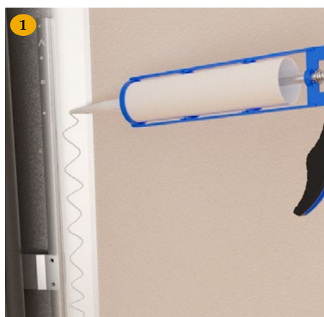
1 Applicering av LIP Skarvlim MSP på Våtrumskassetts fläns/sockel.
